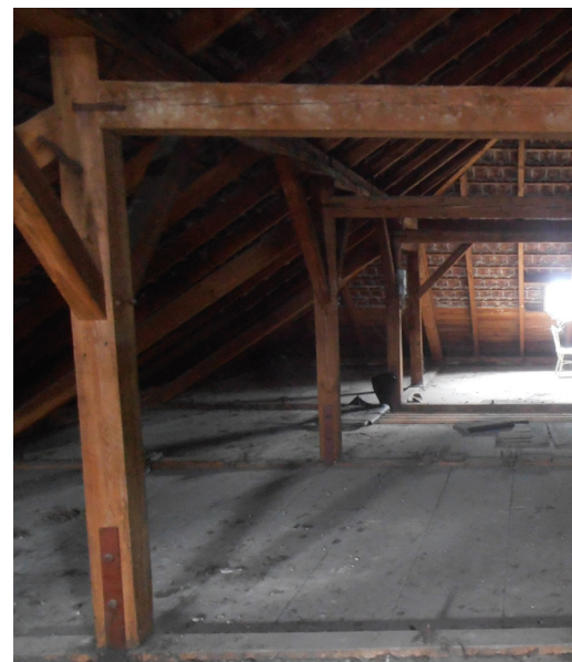
Dachraum vor Umbau attic before reconstruction
