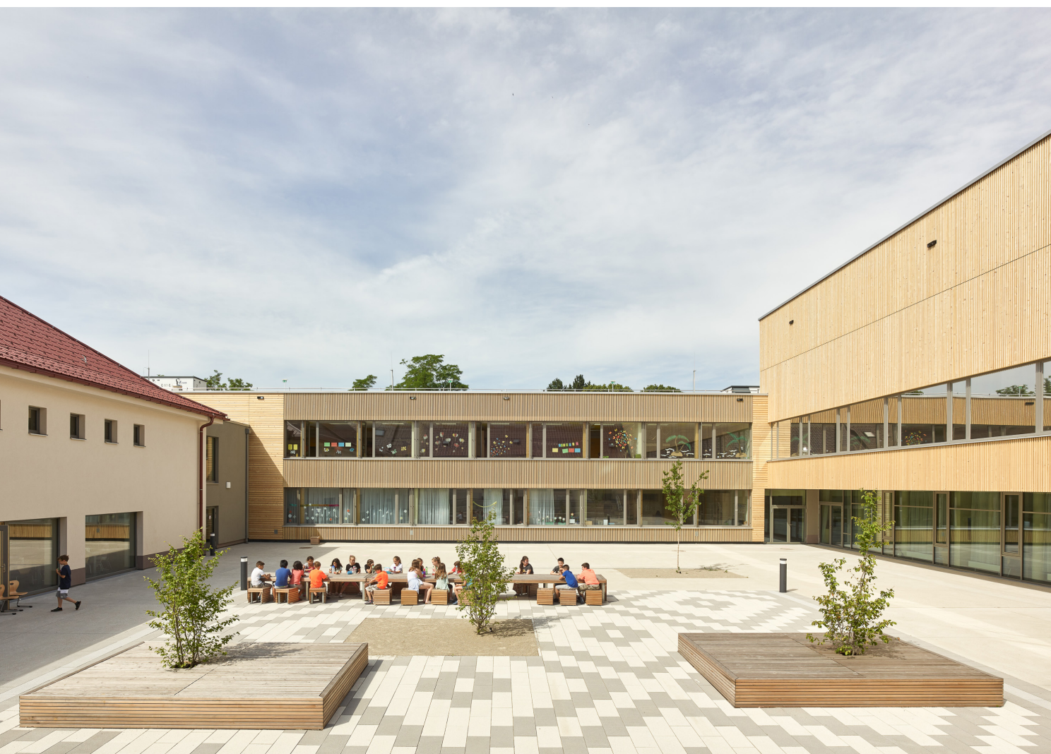
Schulhof nach Umbau courtyard after reconstruction
